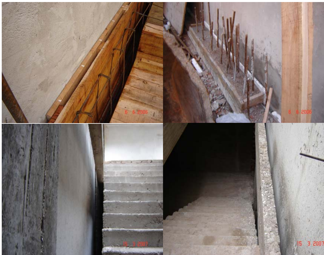
Figuras 7, 8, 9 y 10. Vistas de la desvinculación de los elementos constructivos de H°A°.
