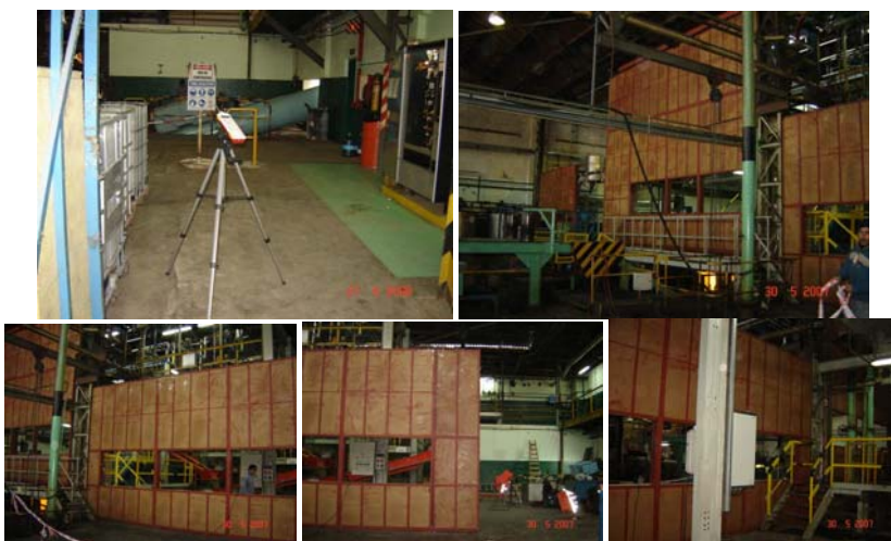
Figuras 46, 47, 48 y 49. Distintas vistas del área y pantallas en la zona del horno.
