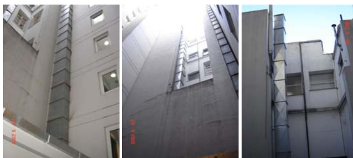
Figuras 42, 43 y 44. Conducto que sale de la cabina, patio interno con los conductos y conducto del vecino agregado posteriormente.
