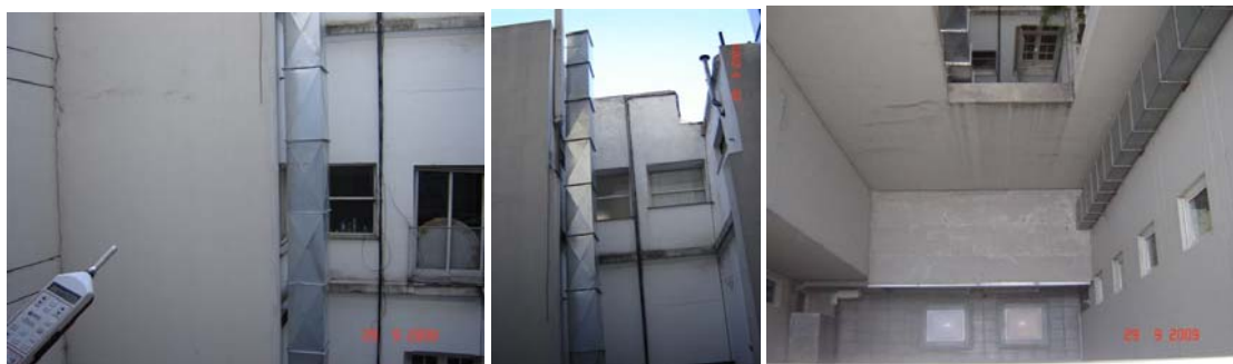
Figuras 28, 29 y 30. Vistas del patio interno hacia edificio vecino y a la cabina, desde piso alto del hotel (conducto que sale del restaurante vecino).
