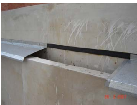
Figura 6. Detalle cierre horizontal en terraza de la doble partición.
