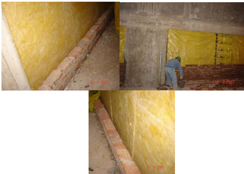
Figuras 2, 3 y 4. Etapa constructiva cerramiento vertical medianero.
