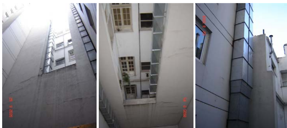
Figuras 25, 26, y 27. Vistas del patio interno hacia edificio vecino desde distintos alturas (conducto que sale del restaurante vecino).
