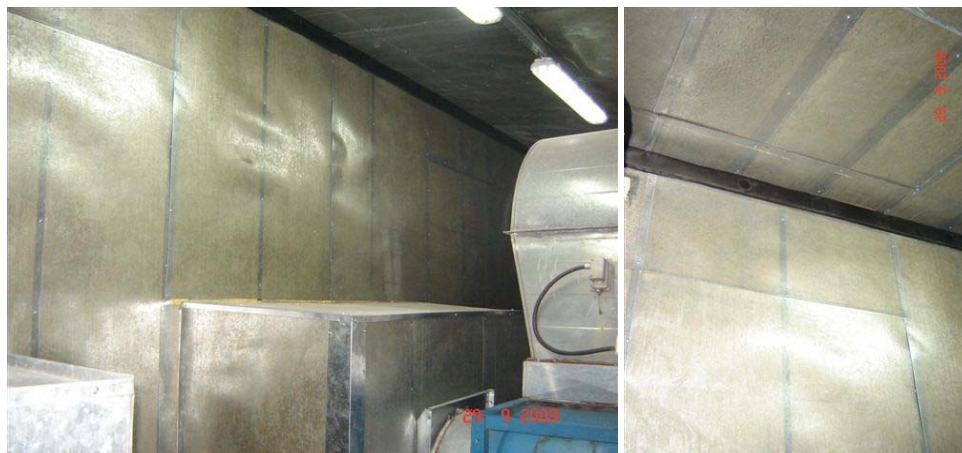
Figuras 18 y 19. Interior de la cabina con el tratamiento en paredes y cielorrasos.
